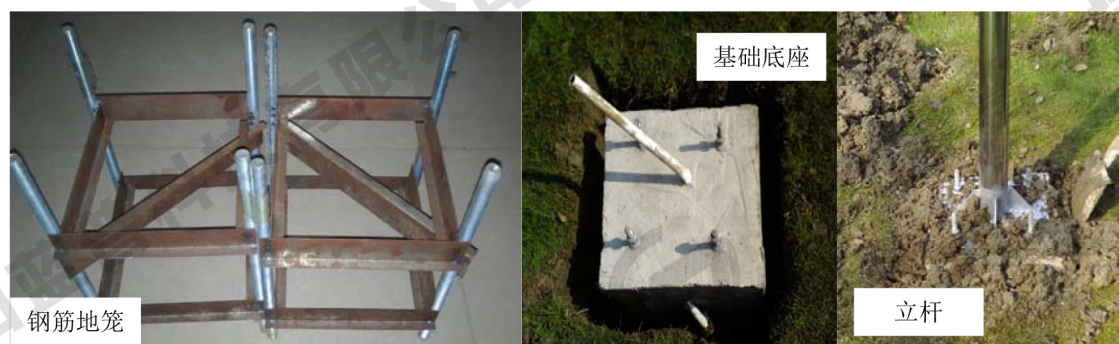
附图B.3.2 底座和立杆施工实物图
